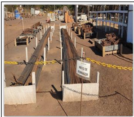
Modelo berço para armazenamento de Ferragens.
