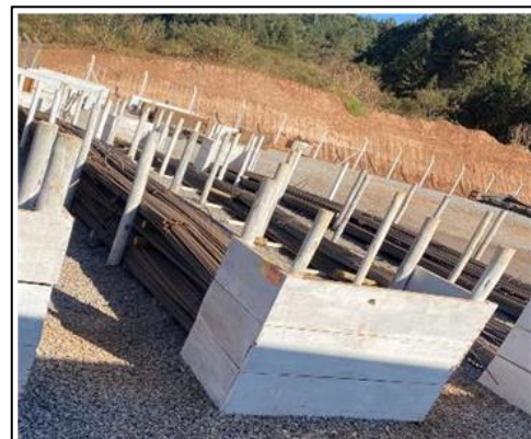
Modelo de gaveteiro para armazenamento de madeira.
