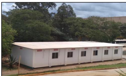
Exemplo de módulos metálicos de containers
