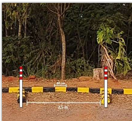
Estacionamento utilizando poste em PVC e batente de madeira
