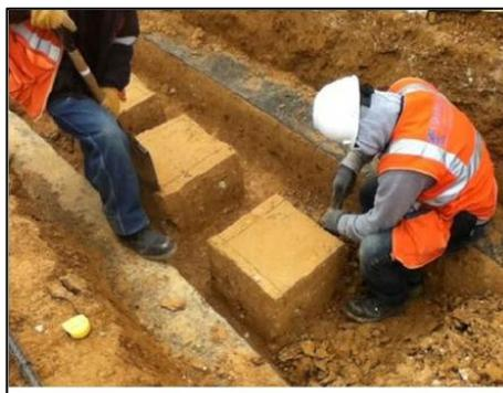
**Figura 42** - Exemplo de bloco indeformado
