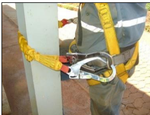
Figura 3 - Uso de Tie Back
