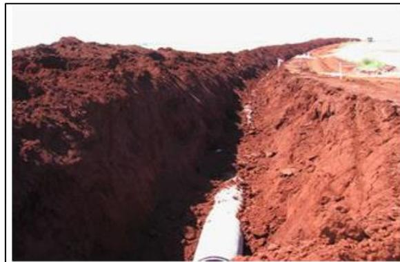
**Figura 2** - Exemplo inadequado de vala sem escoramento e sem a estabilidade garantida.
